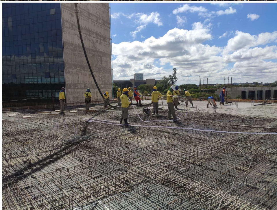
Foto 08 –Laje de concreto armado.
