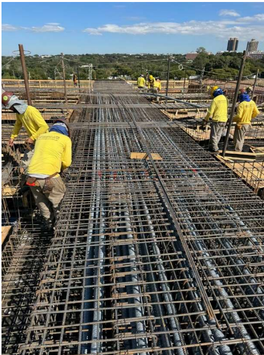
Foto 04 – Vigas de concreto armado.
