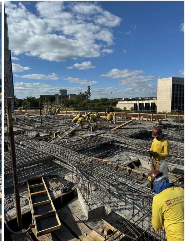
Foto 05 – Vigas de concreto armado.
