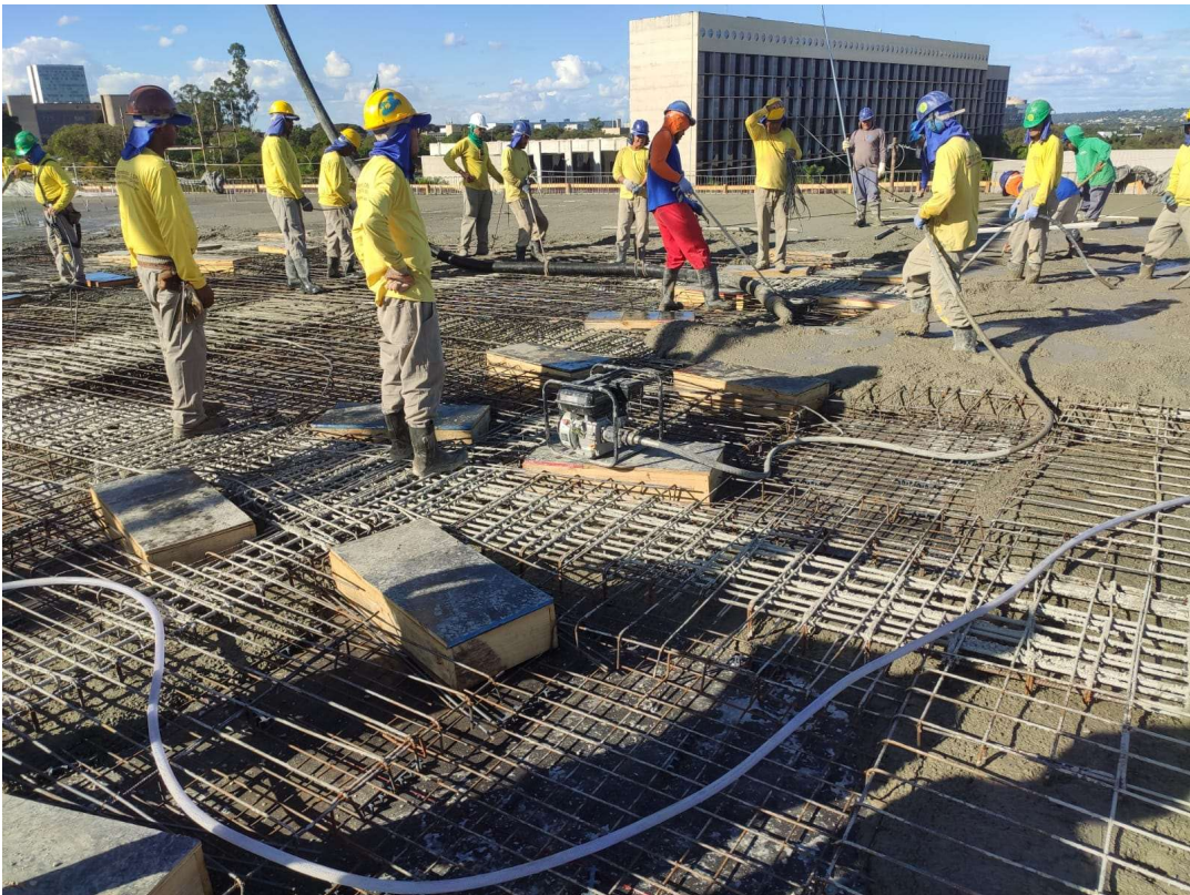
.Foto 02 – Vigas de concreto armado
