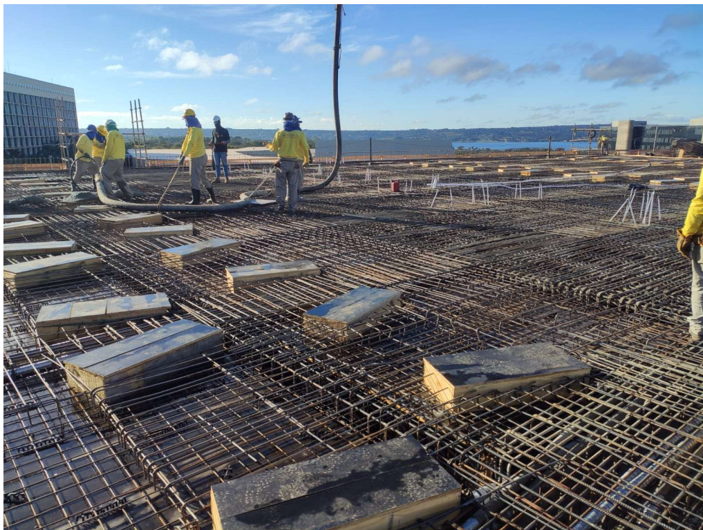
Foto 03 – Vigas de concreto armado
