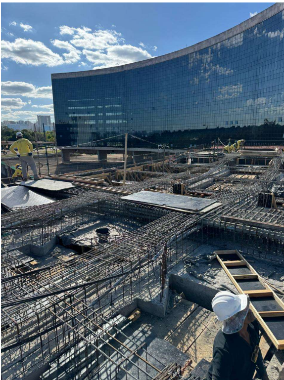
Foto 05 – Vigas de concreto armado.
